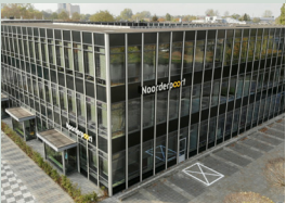
Verduurzaming ROC Noorderpoort
