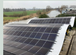
Verstevigde constructie steunpunt Terborg
