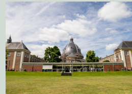
College Hageveld bereid voor op lage temperatuur- verwarming
