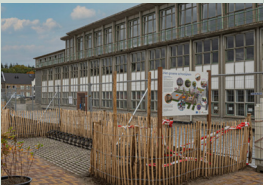
Kantine gebouw Enka wordt Frisse School klasse B
